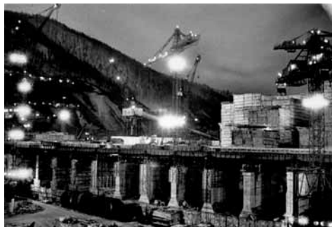
Строительство Красноярской ГЭС — видно, что тело плотины формируется из огромных блоков, каждый из которых заливается по отдельности.
